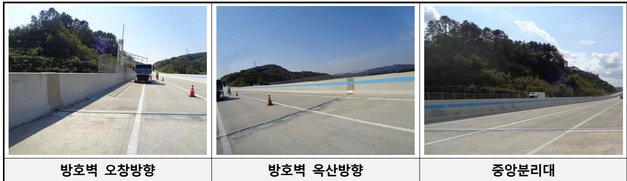
[방호벽 및 방음벽 전경]
