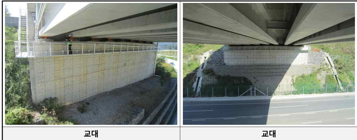
[교대 및 교각 전경]
